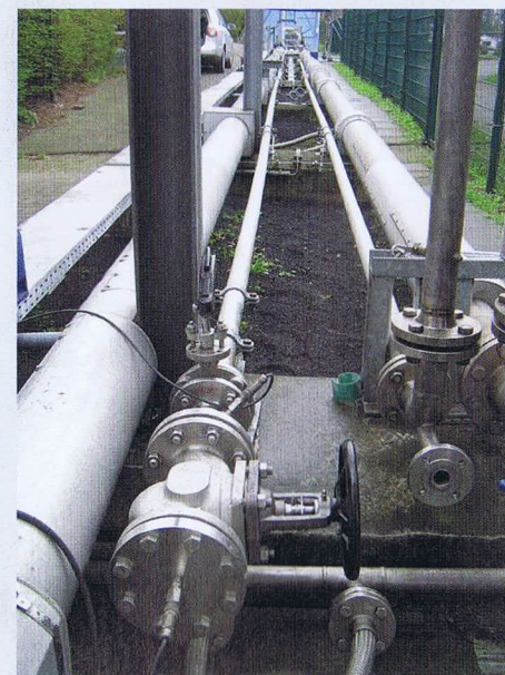
Bild 3: Versuchsventil am Ende der Stichleitung
